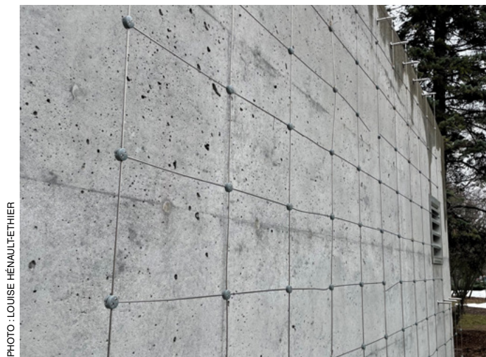
Figures 12 et 13 – Réseau de câblage dense.
