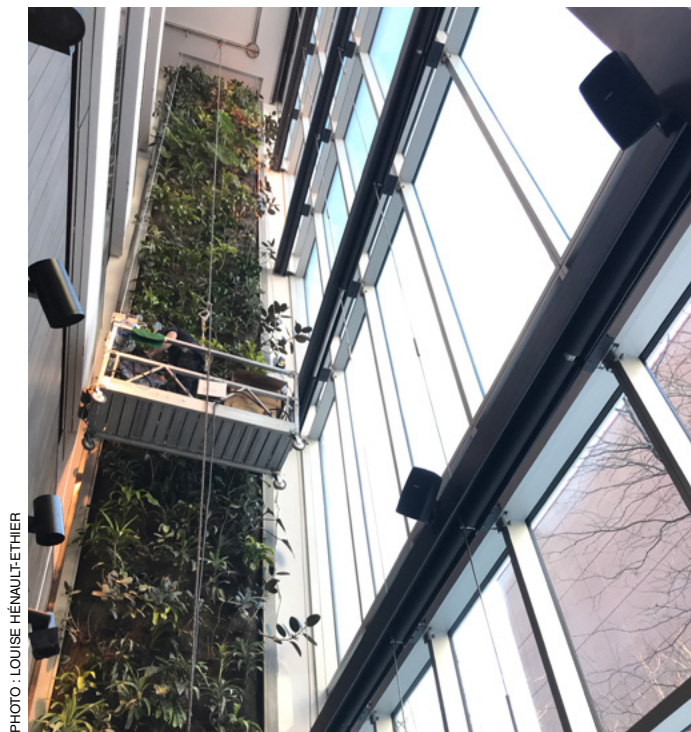
Figure 15 – Entretien d'un mur végétalisé à l'aide d'une nacelle.
