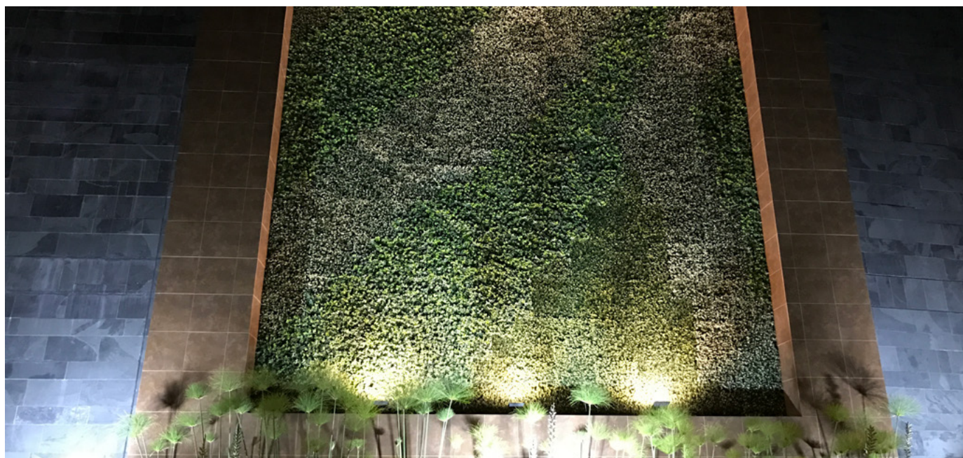
Figures 27, 28 et 29 – Si les murs végétalisés extérieurs sont plus faciles d'entretien dans les pays tropicaux, comme ces trois exemples de Colombie, ils peuvent aussi être implantés au Québec.
