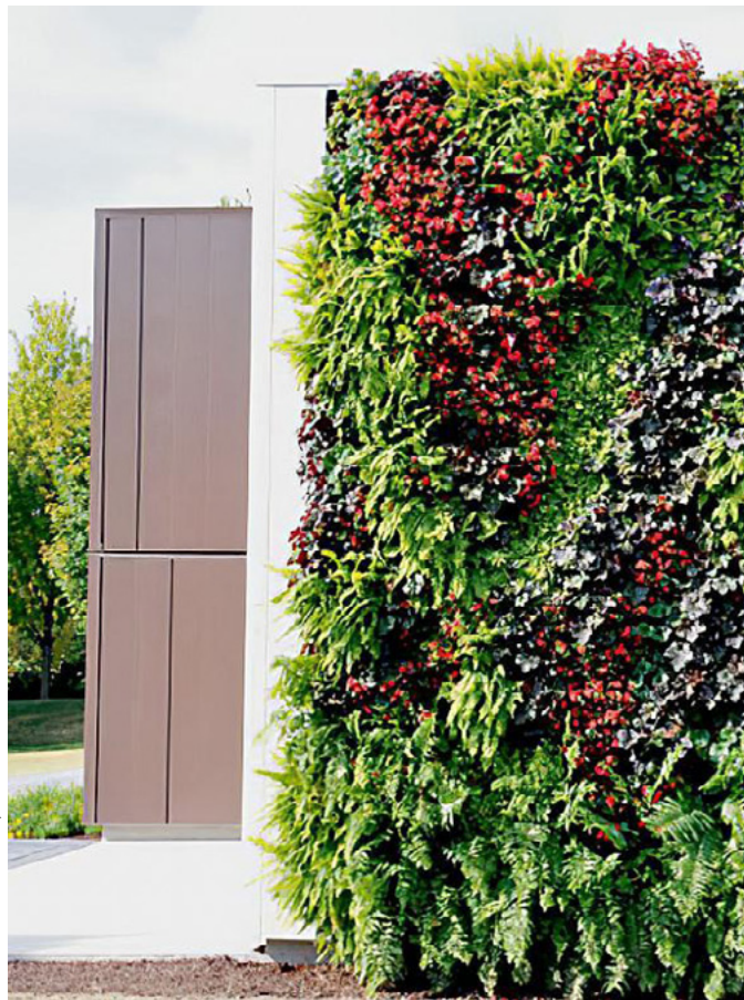
Figure 32 – Mur végétal modulaire avec substrat présent au pavillon horticole écoresponsable de l'ITA.
