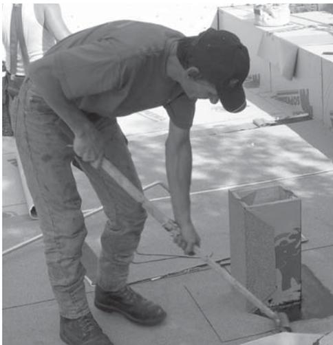
Soudage de la membrane de finition autour d'une sortie mécanique
