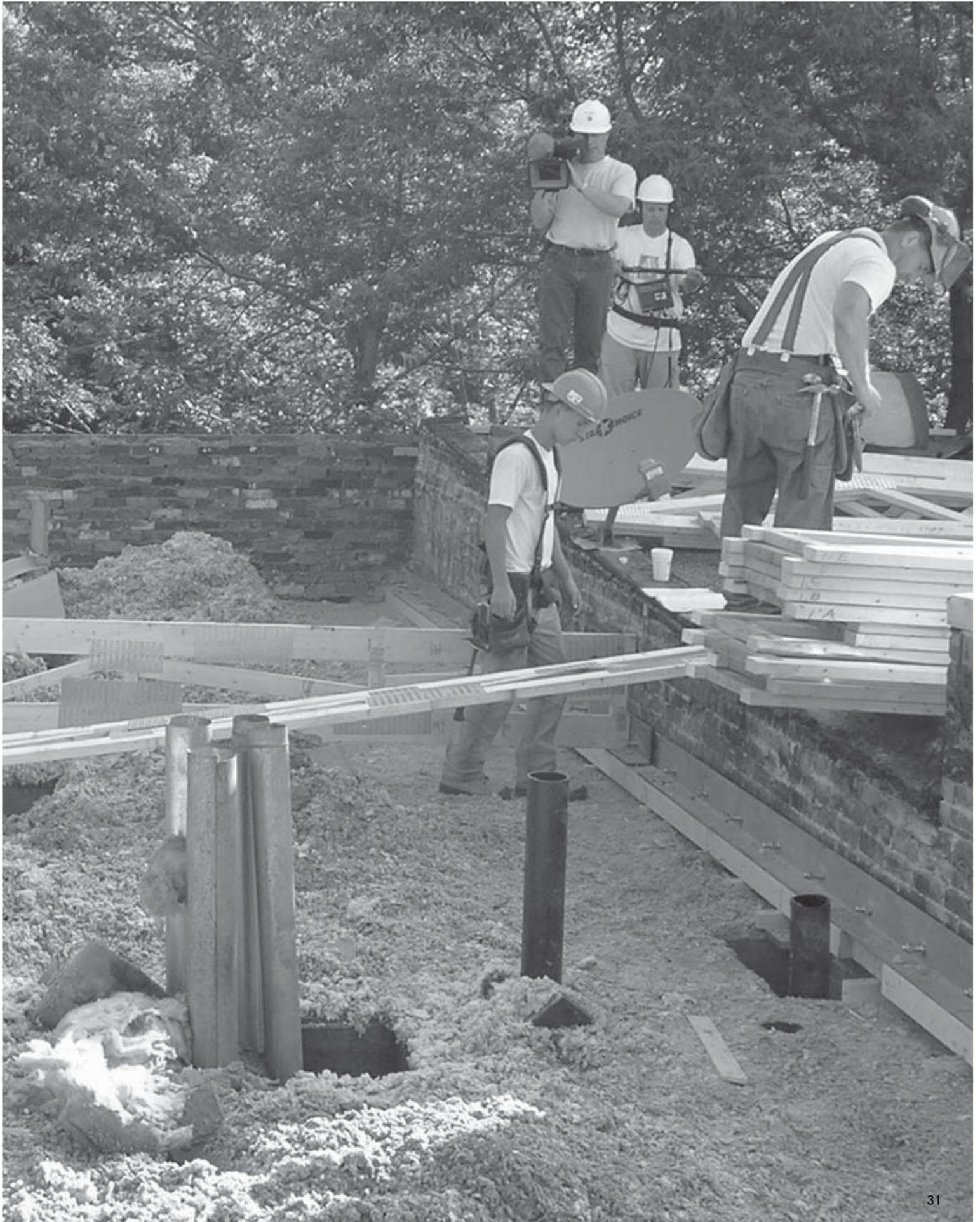
Il est pratique d'installer les premières fermes de toit aux abords d'une sortie mécanique et ainsi aménager le contour, ce qui demande de couper en deux une ferme de toit et de fixer les fermes à l'aide d'une structure de bois fabriquée sur place.
