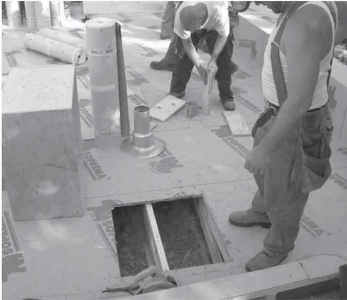
Les deux trappes sont découpées dans le contreplaqué; deux boîtes sont construites aux dimensions données et sont installées dans les trous, et le tout est recouvert d'une sous-couche d'étanchéité.
