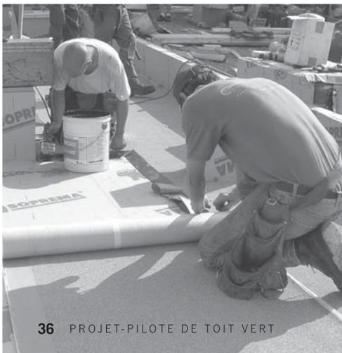
Application de la membrane de finition autour d'une sortie mécanique
