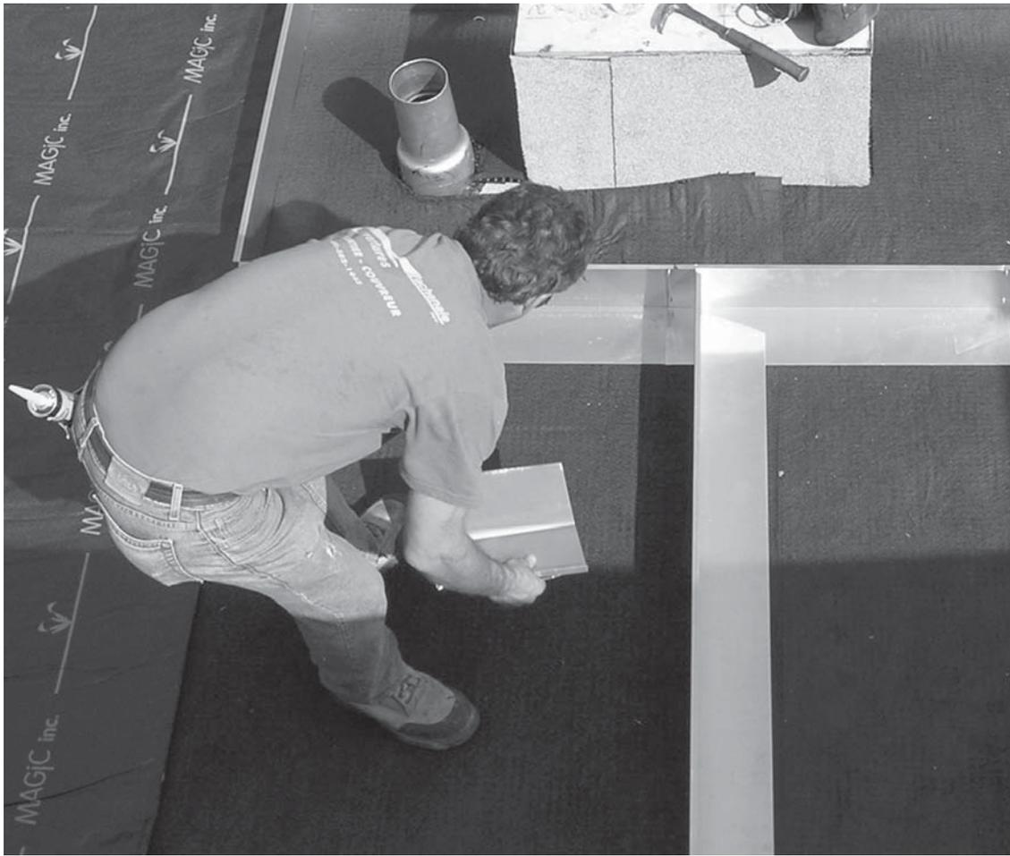
Bordure en aluminium divisant le toit en deux et entourant les sorties mécaniques
