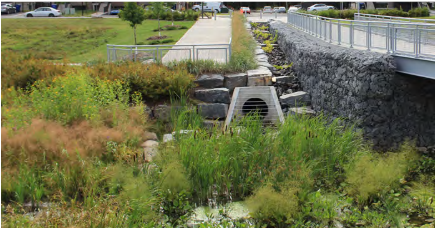
Photo 8 : Intégration de l'entrée du réseau dans le bassin, parc des Semis, Longueuil
