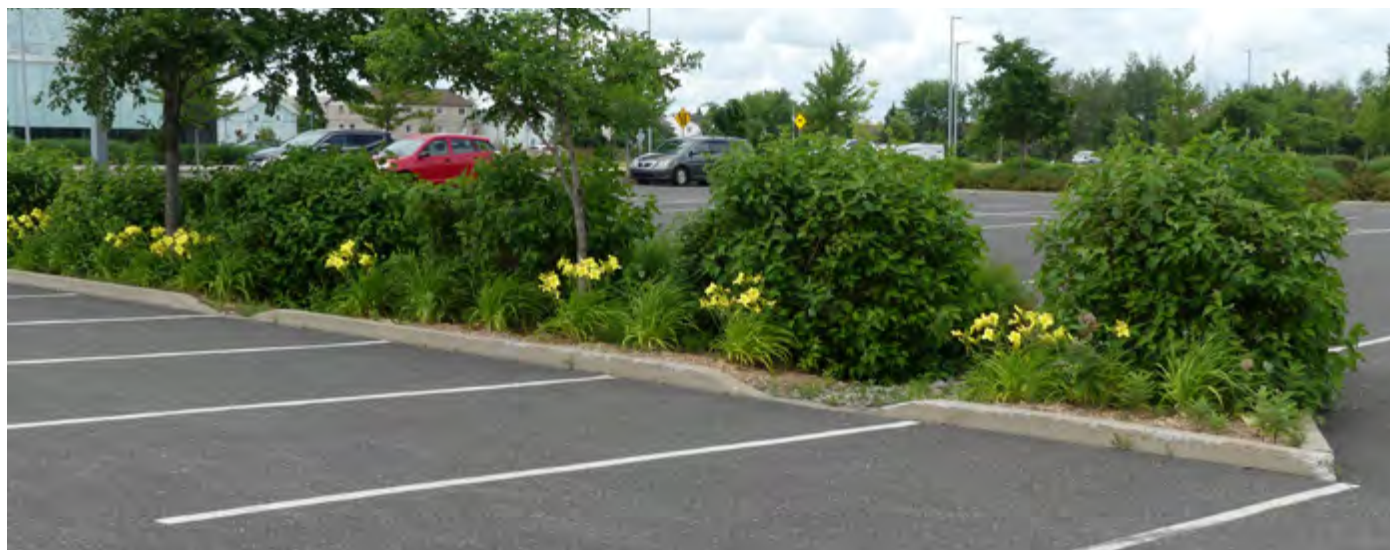
Photo 3 : Îlot de biorétention, stationnement centrexpo, Ville de Drummondville
