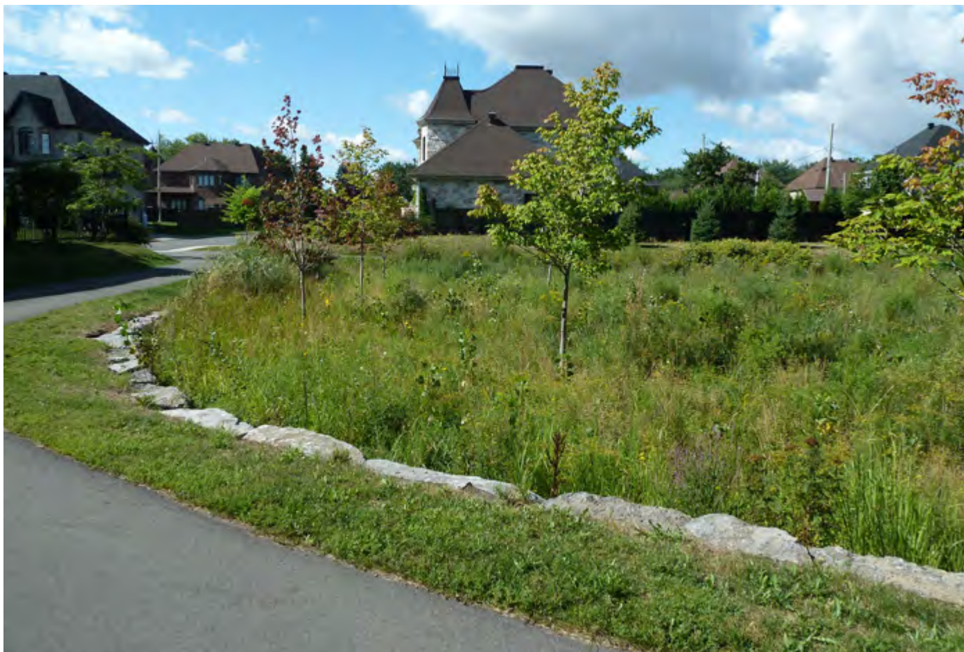
Photo 10 : Bassin à retenue prolongée au parc Clichy, Laval
