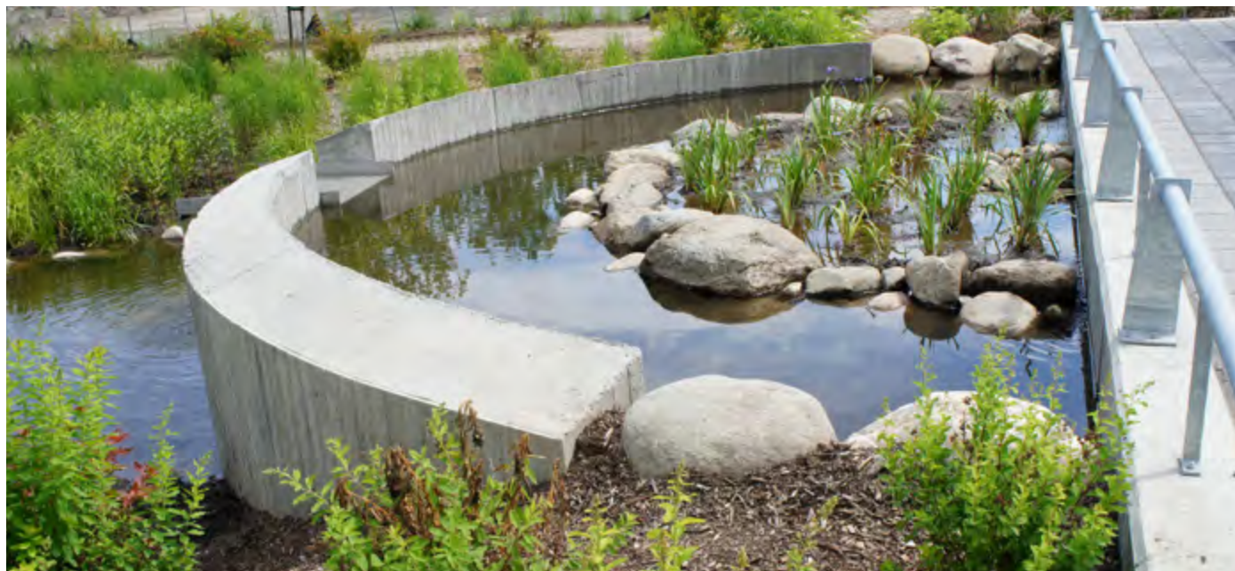
Photo 4 : Bassin de sédimentation au parc Gewurz-Remer, Montréal
