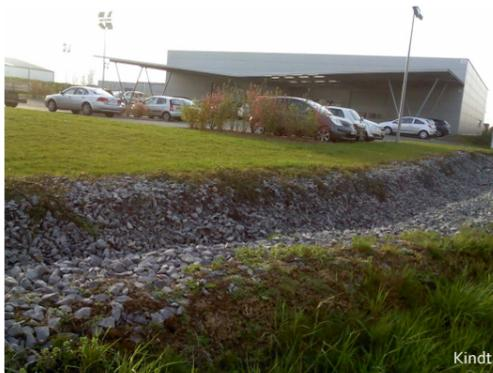
Cette entreprise nordiste infiltre les eaux de pluie de ses surfaces perméables par une noue dont les berges sont maintenues par enrochements.
