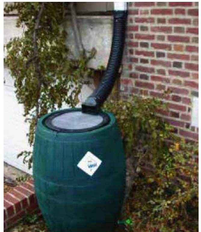
Figure 11.18 Exemple d'installation avec un baril pour la réutilisation de l'eau de ruissellement provenant d'un toit.
