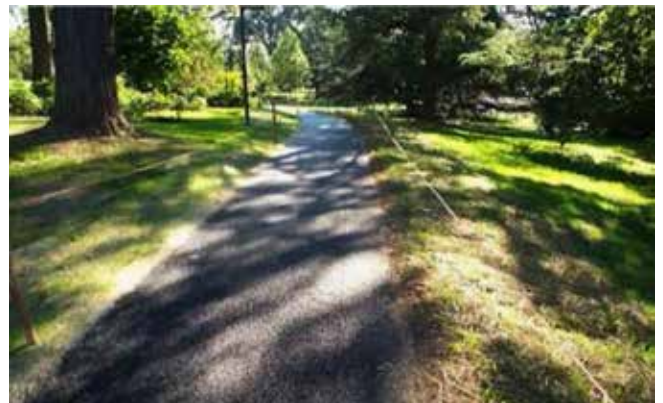
Figure 11.43 Aménagement de piste cyclable avec de l'asphalte poreuse.
