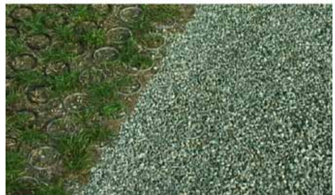
Figure 11.42 Système de pelouse renforcée (GVSD, 2005).
