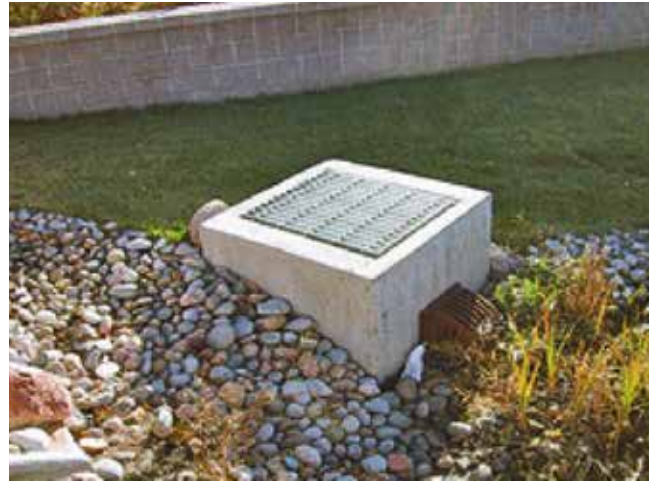
b. Ouvrage de sortie avec une grille.
