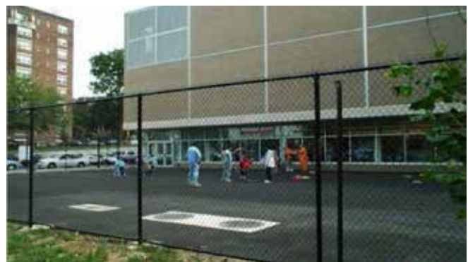
Figure 11.44 Aménagement d'une cour d'école avec un revêtement poreux.
