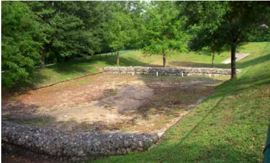
Figure 11.89 Aménagement d'un filtre à sable de surface.
